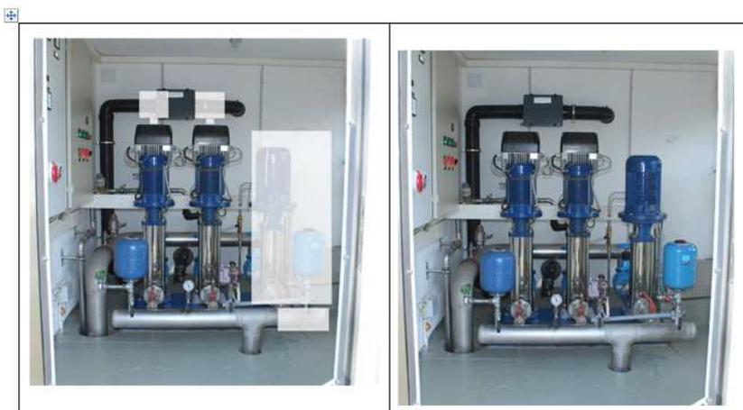
Fig. 24 A destra la foto con la situazione attuale del locale comandi, a sinistra con 2 pompe nuove + volano d'inerzia sopra il motore
